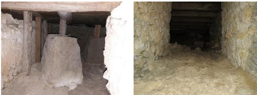
F:A Fig. 47 – Suportes de pavimento: blocos de pedra de apoio a vigas e paredes de pedra
